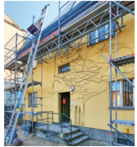
Maßnahmen in der Röblingstraße 37/39 im Jahr 2023
